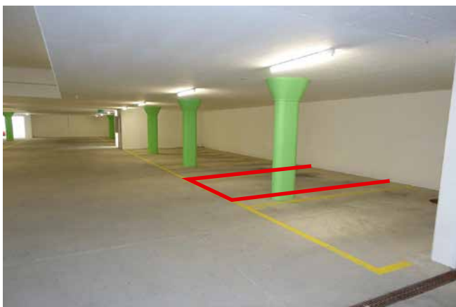
Der Tiefgaragenparkplatz Nr. 2
