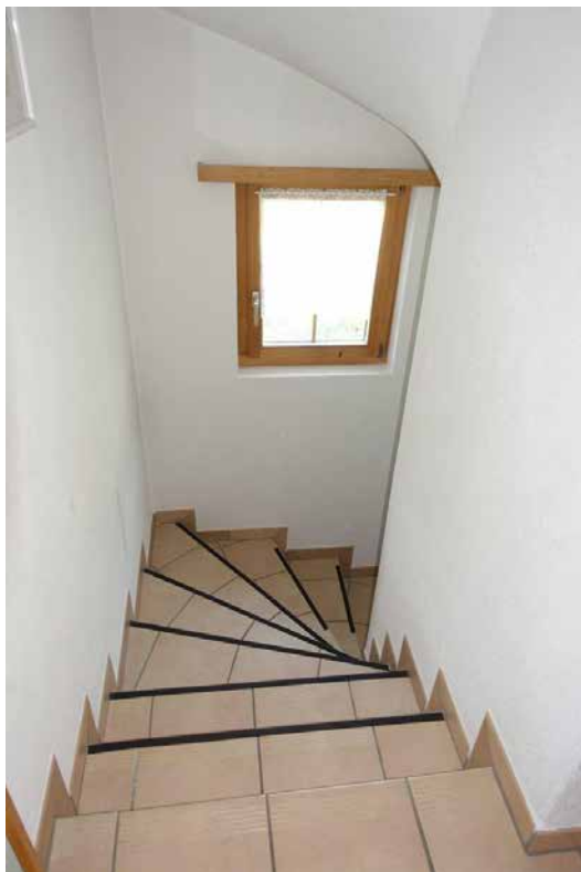
... sowie Treppen ins Untergeschoss.
