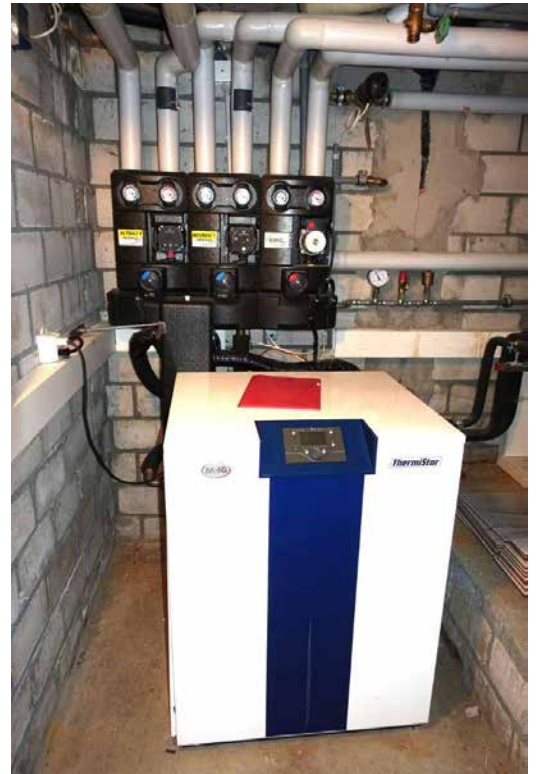
Die Erdsondenheizung
