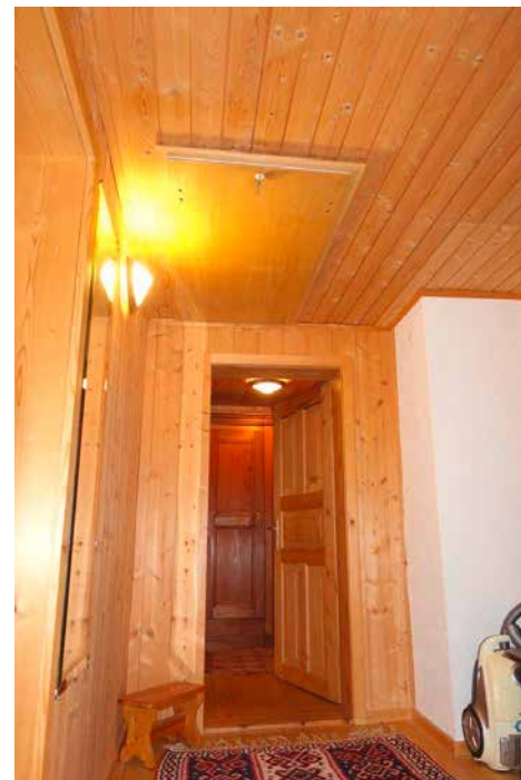
Der Zugang zum Estrich
