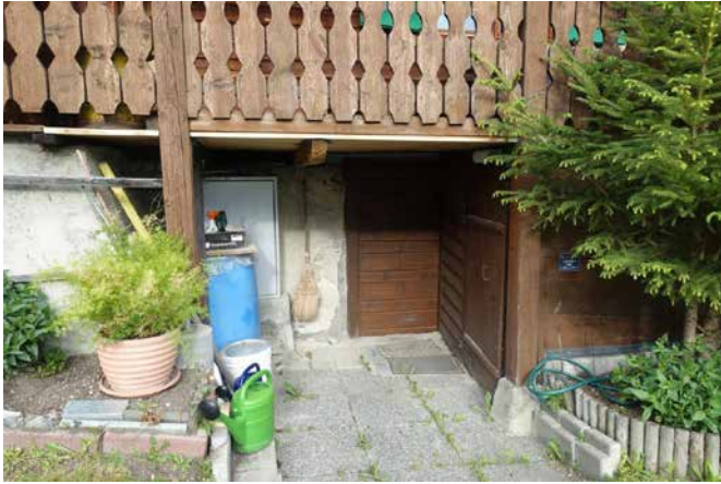
Der Zugang zu den Kellerräumen
