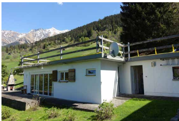
Die 2½-Zimmer-Wohnung mit grossem Gartensitzplatz und Gartenhäuschen
