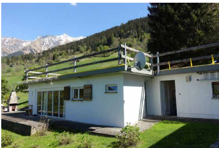
Die 2½-Zimmer-Wohnung mit grossem Gartensitzplatz und Gartenhäuschen
